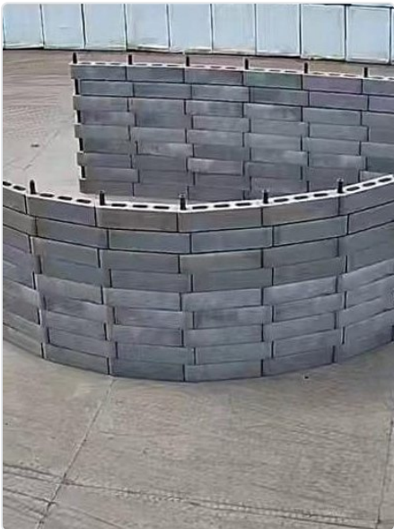
СБОРКА СУХОЙ СТЕНЫ
